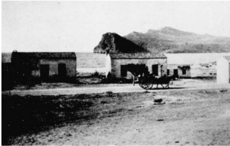
Ay Marina, Crete Ay Marina, Crete
